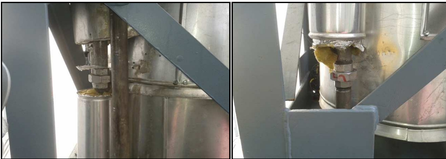
Rysunek 16: Miejsca łączeń rurociągów sorbentu gdzie zauważono wycieki (rys. lewy – K-201 poziom +7m; rys. prawy – K-215 poziom +3m)
