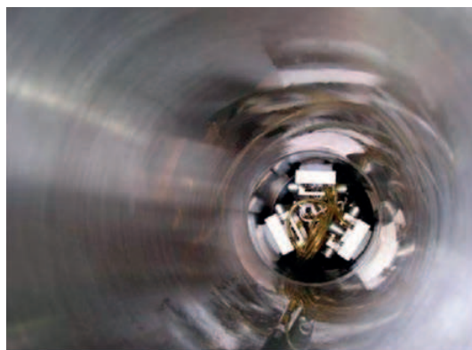
Fot. 3. Badanie otworu centralnego za pomocą skanera ultradźwiękowego
