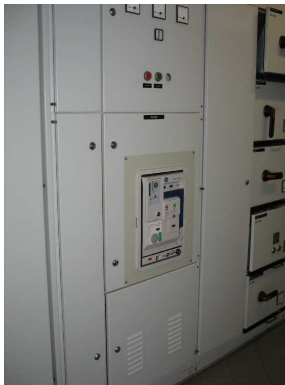
Pole zasilające rozdzielni potrzeb własnych 0,4kV 12R4
