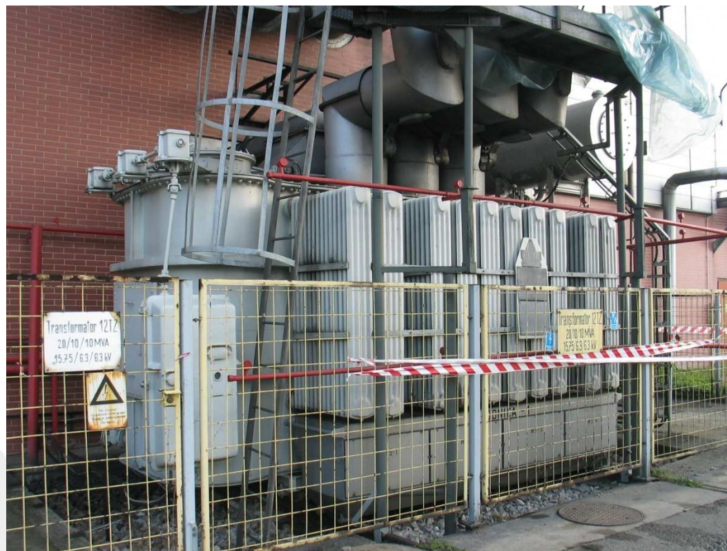
Transformator zaczepowy
