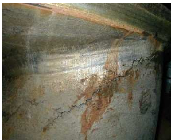
Rys. 4. Uszkodzenia wirnika pompy fabryczne j.
