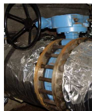
Zdjęcie 2 Przepustnica w instalacji komory ciepłowniczej
