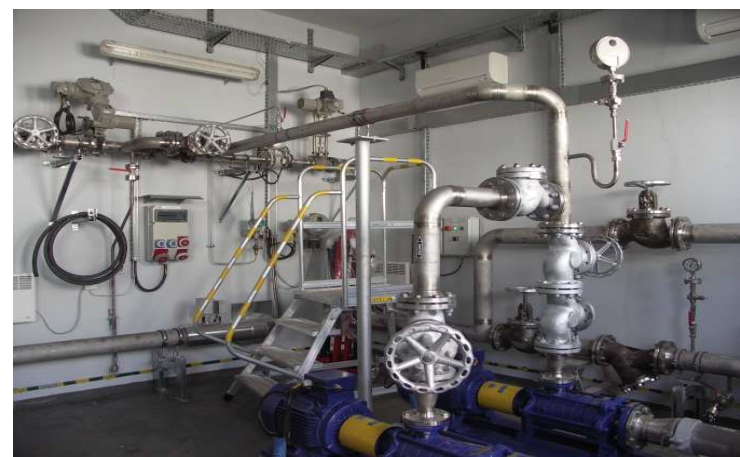
Stanowisko rozładunku cystern i pompownia
