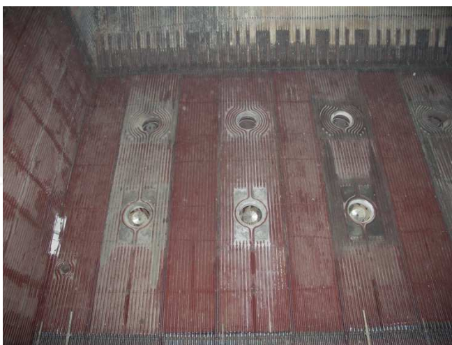
Dysze OFA i powietrza osłonowego tył kotła
