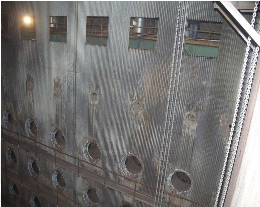
Przednia ściana kotła po zdemontowaniu starych palników i wycięciu miejsc pod zabudowę nowych dysz OFA
