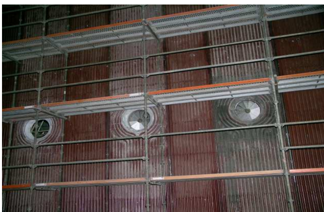
Dysze OFA i powietrza osłonowego tył kotła
