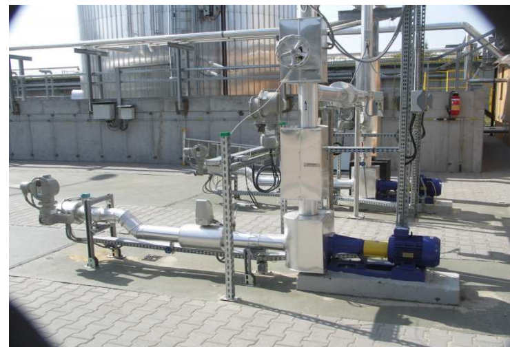
Stanowisko rozładunku cystern i pompownia
