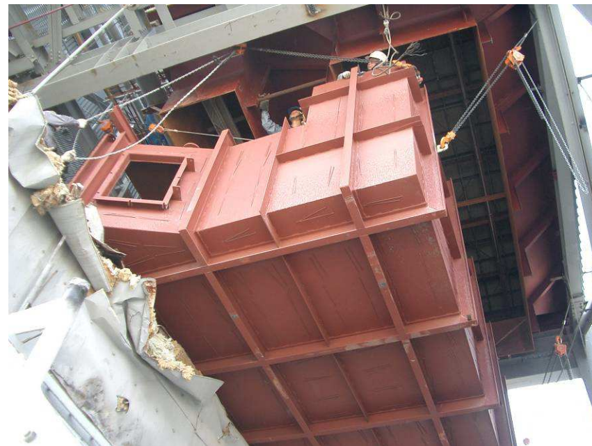
Montaż nowego kanału spalin od ECO do reaktora SCR
