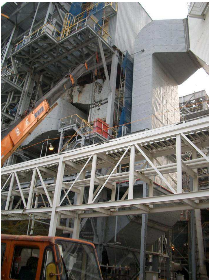
Usuwanie kanałów spalin od ECO do podgrzewacza powietrza (APH)
