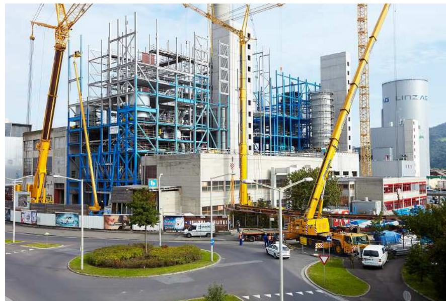
Budowa elektrowni, tereny przemysłowe, Linz
