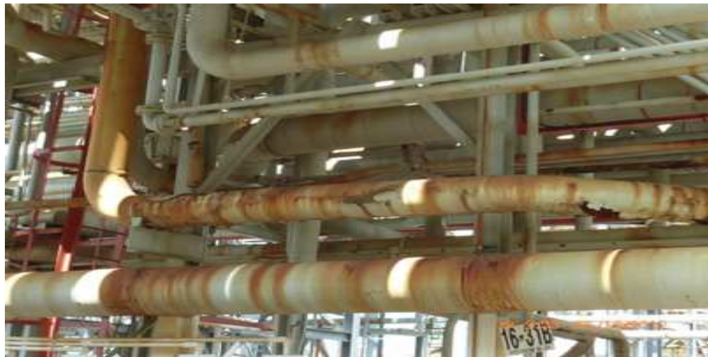
Tak może wyglądać rurociąg po usunięciu izolacji
