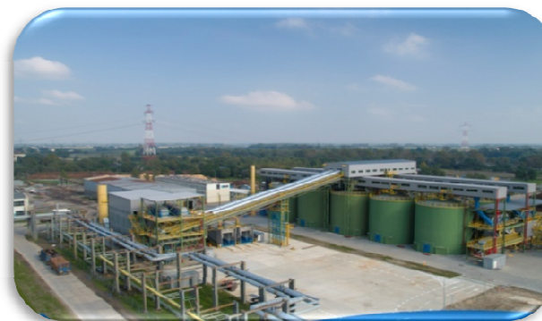
Instalacja do rozładunku i magazynowania biomasy Agro
