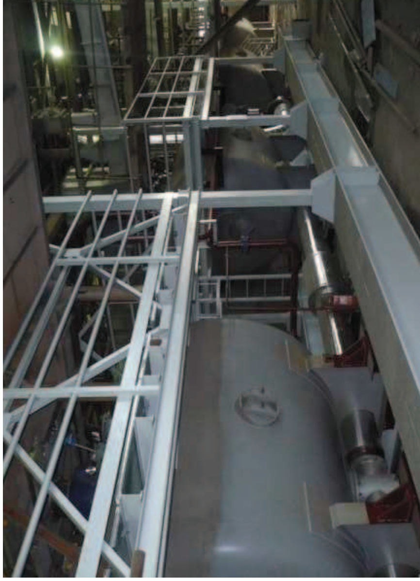
12 m 3 zbiorniki ciśnieniowe transportujące- Obrenovac, Serbia
