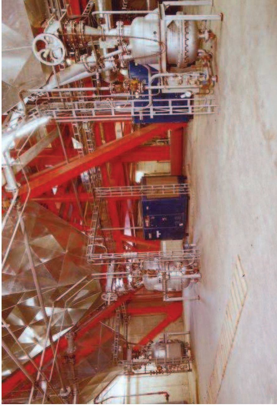
Transport gęstych faz z lejów ESP - Leykam Gratkorn złoże fluidalne, Austria
