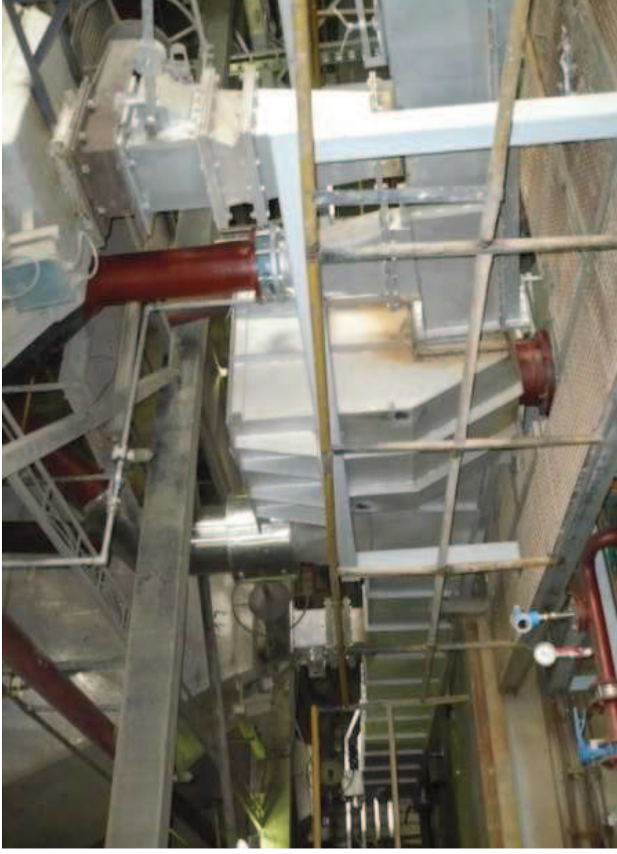
Podajniki pod ESP - Obrenovac, Serbia
