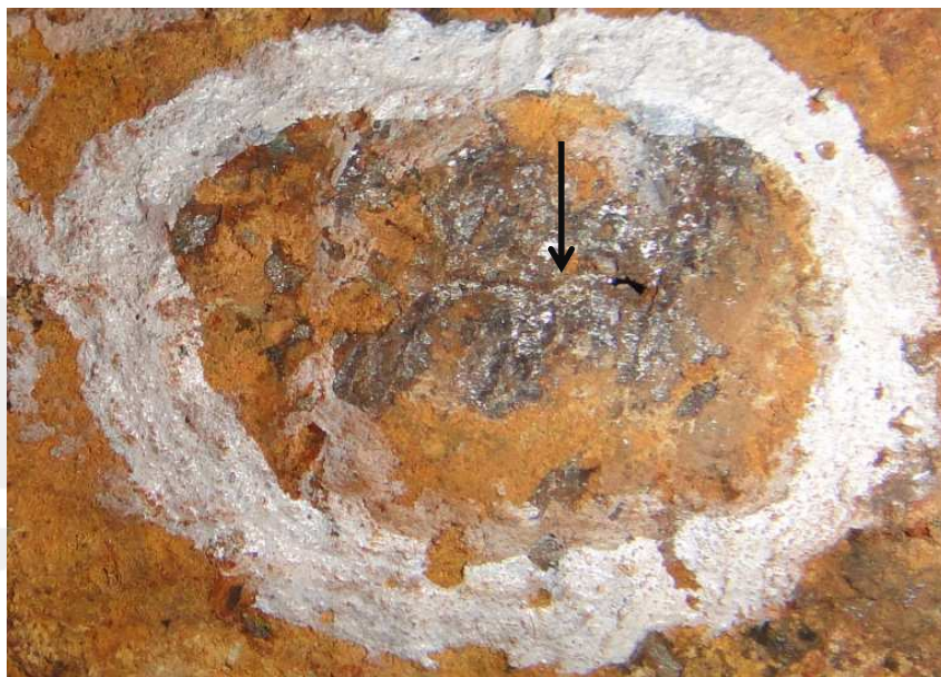
Widoczne pęknięcia od zewnątrz
