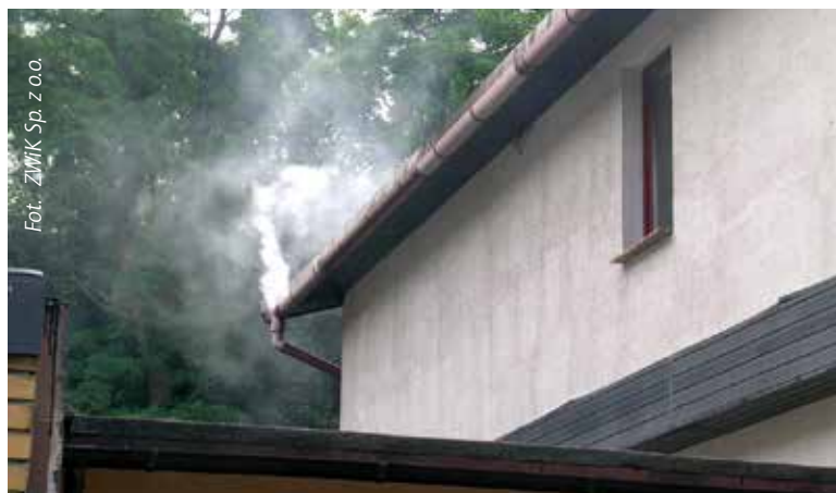
FOT. 5 Zadymianie kanalizacji w poszukiwaniu połączeń deszczowych
