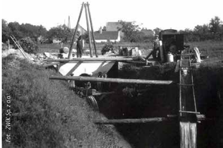
FOT. 1 Budowa wylotu kolektora głównego w rejonie ul. Węglowa z 17.07.1929 r.
