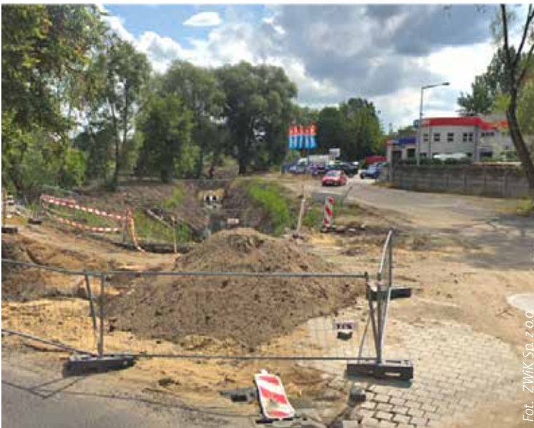
FOT. 3 Przebudowa cieku Łączy na ul. Węglowej
