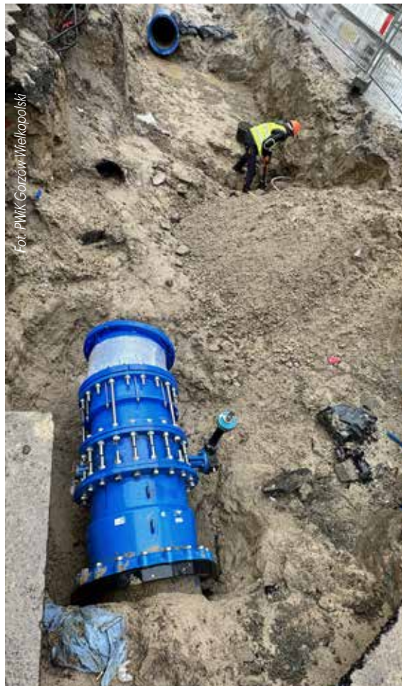
RUROCIĄG DN 600 mm
