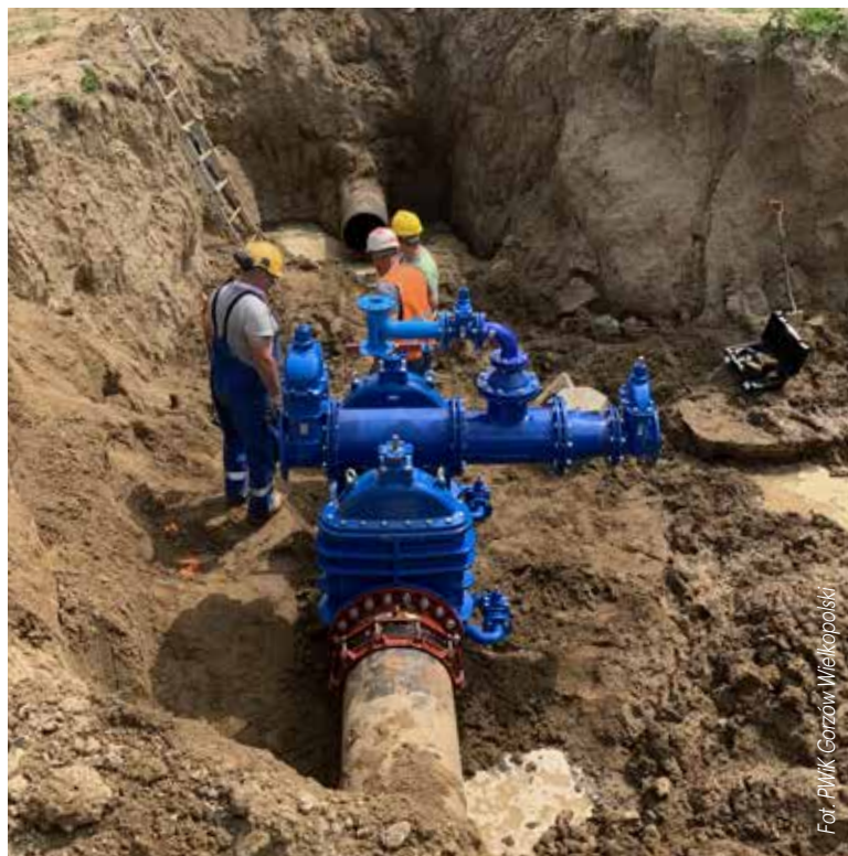
WĘZEL ZASUW DN 500 mm
