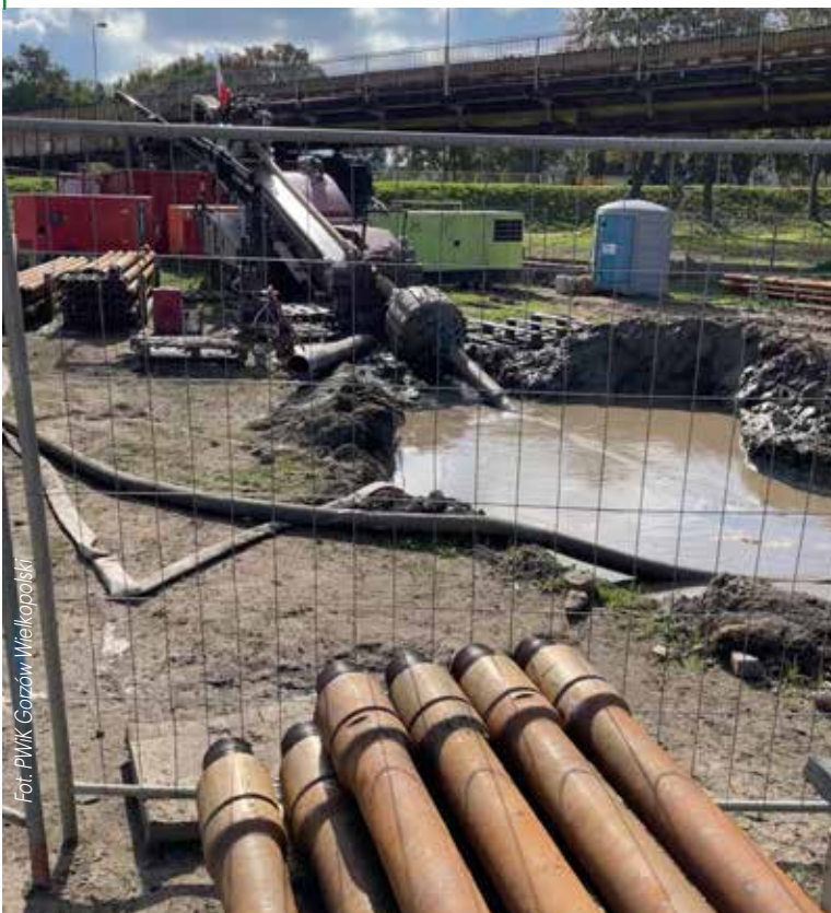
MASZYNA PRZEWIERTOWA z rozwiertakiem, przewiert rz. Warta
